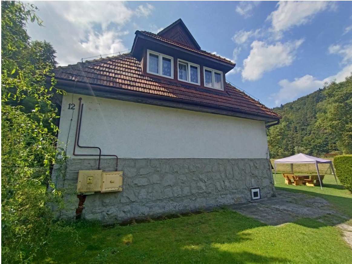
WEJŚCIE DO BUDYNKU
