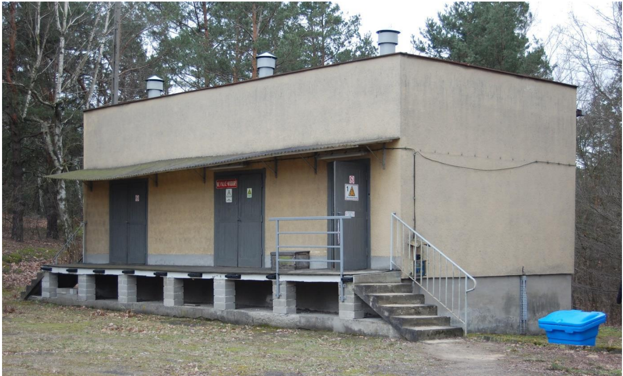
Magazyn butli wodorowych
