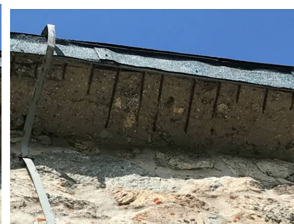
Brak otuliny zbrojenia w okapach płyty stropodachu
