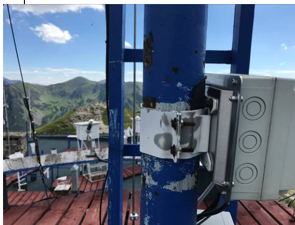
Ubytki powłok malarskich w miejscu mocowania urządzenia pomiarowego
