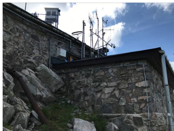
Okładzina kamienna ścian zewnętrznych
