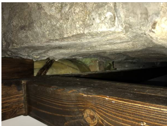
Dylatacja pomiędzy ścianą obserwatorium a przybudówką
