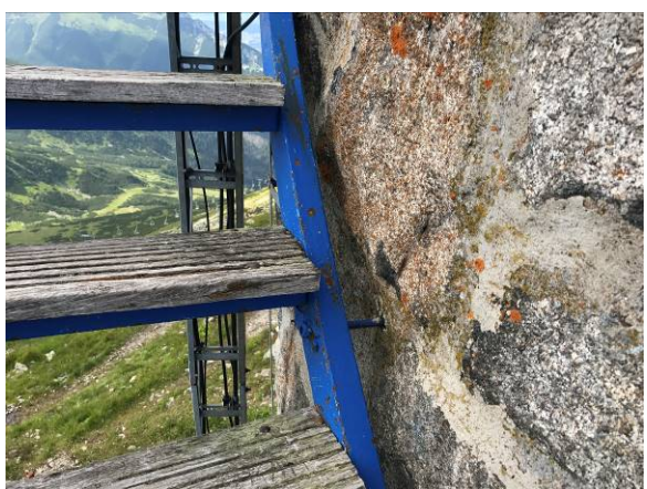
Stopnie drewniane schodów prowadzących na stropodach rotundy | 58
