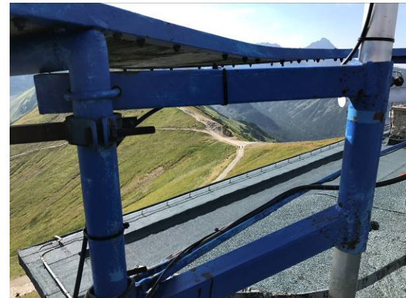
Konstrukcja wsporcza blatów do mocowania urządzeń pomiarowych
