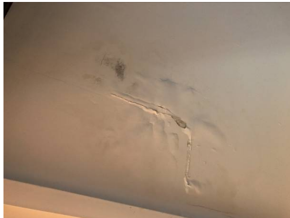
Zacieki i pęknięcia na stropie (płyty G-K) w przybudówce
