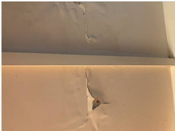
Zacieki na stropie (płyty G-K) w przybudówce
