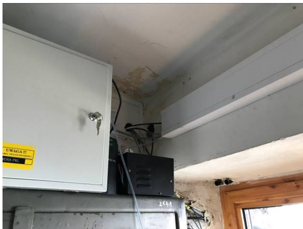
Zacieki na ścianach w pracowni AGH | 16 | 17 | Ubytki i pęknięcia tynku – pracownia AGH
