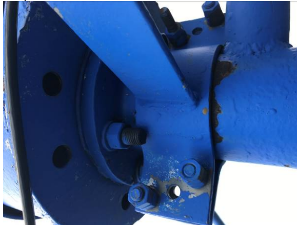
Ubytki powłok malarskich w miejscu mocowania obejm stalowych
