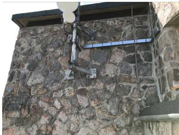
Widok elewacji i ubytki w spoinowaniu
