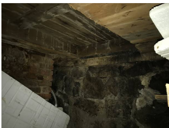
Nie zdemontowane szalunki stropu w | 14 | 15 | Nie zdemontowane szalunki stropu w pomieszczeniu przy klatce schodowej | 14 | 15 | Nie zdemontowane szalunki stropu w pomieszczeniu przy klatce schodowej
