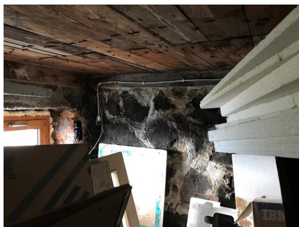
Nie zdemontowane szalunki stropu w | 14 | 15 | Nie zdemontowane szalunki stropu w pomieszczeniu przy klatce schodowej | 14 | 15 | Nie zdemontowane szalunki stropu w pomieszczeniu przy klatce schodowej
