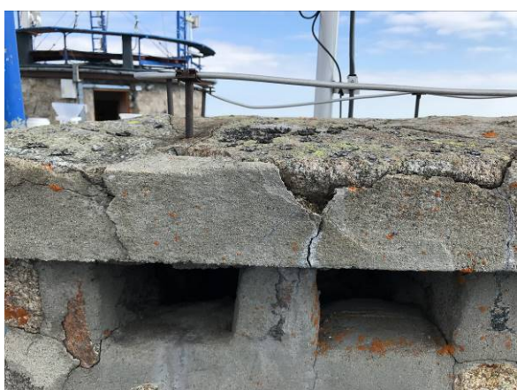
Pęknięcia i odspojenia w płycie przykrywającej przewody wentylacyjne
