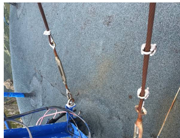
Skorodowane stężenia ramy łukowej na rotundzie
