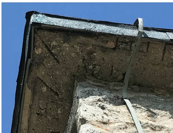
Brak otuliny zbrojenia w okapach płyty stropodachu
