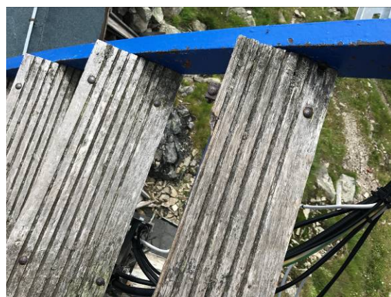
Stopnie drewniane schodów prowadzących na stropodach rotundy – brak powłok zabezpieczających drewno przed korozją biologiczną
