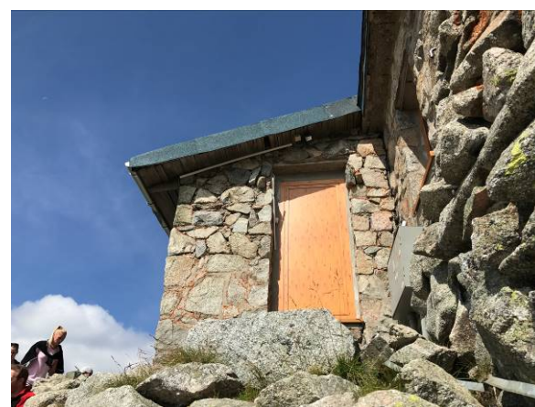
Widok elewacji i ubytki w spoinowaniu
