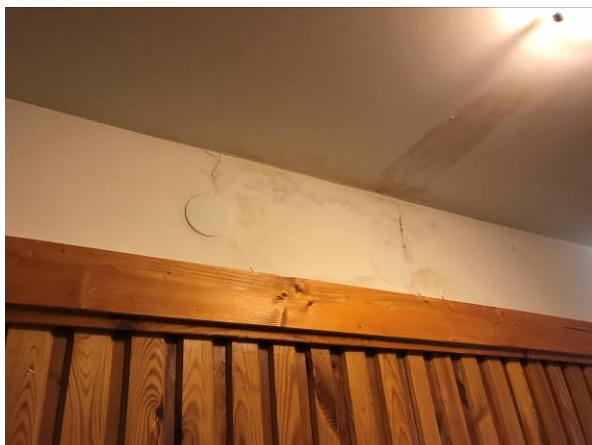
Zacieki na stropie korytarza | 10 | 11 | Widok na strop korytarza
