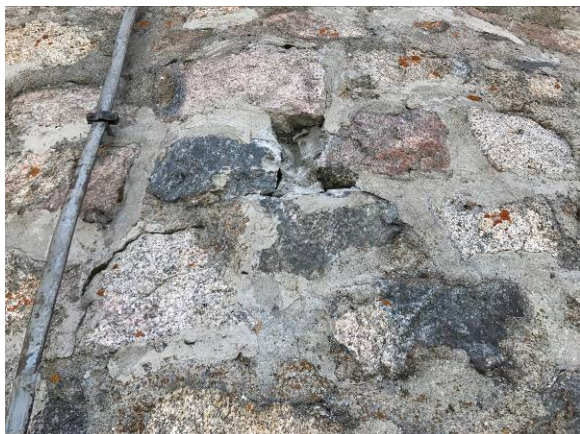
Przewód odprowadzający instalacji odgromowej i ubytki w spoinowaniu elewacji ściany wieży
