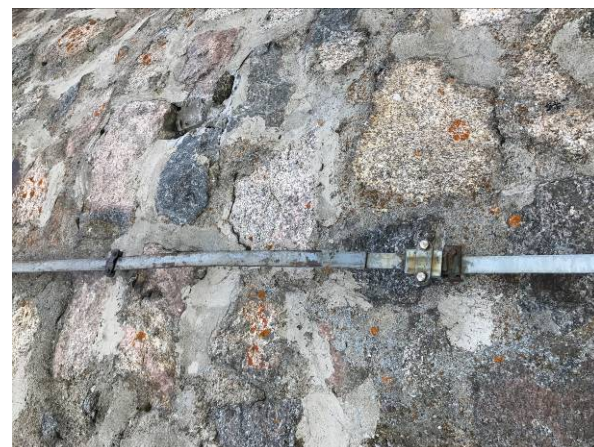
Przewód odprowadzający instalacji odgromowej na ścianie wieży
