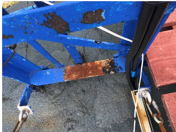
Ubytki powłok malarskich elementów stalowych masztu i ramy łukowej i ogniska korozji | 61
