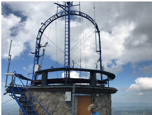
Rama łukowa z masztem na rotundzie budynku
