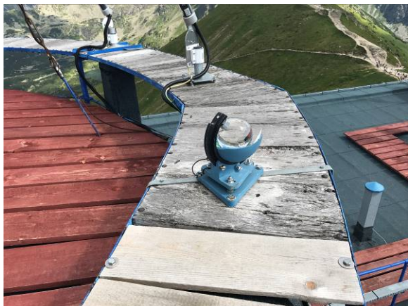
Blaty z desek drewnianych do mocowania urządzeń pomiarowych – brak powłok zabezpieczających drewno przed korozją biologiczną
