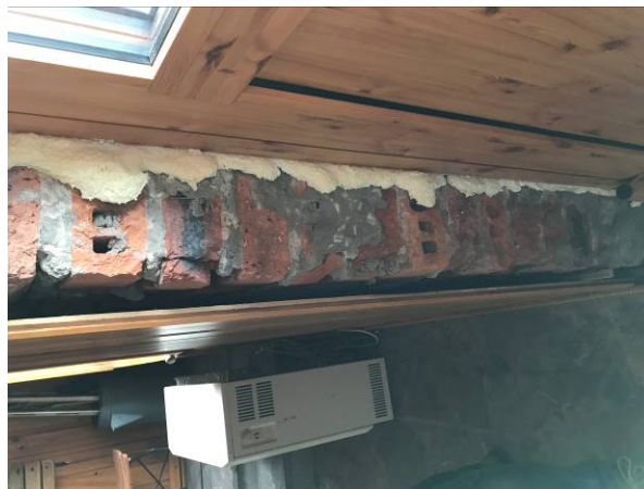
Widoczny fragment warstw wewnętrznych ściany od stropy wejścia do budynku
