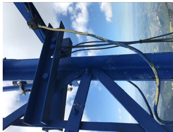
Ubytki powłok malarskich elementów stalowych masztu i ramy łukowej i ogniska korozji
