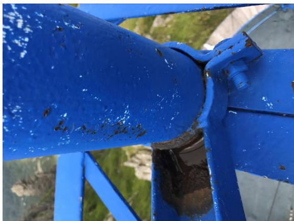
Ubytki powłok malarskich elementów stalowych masztu i ramy łukowej i ogniska korozji
