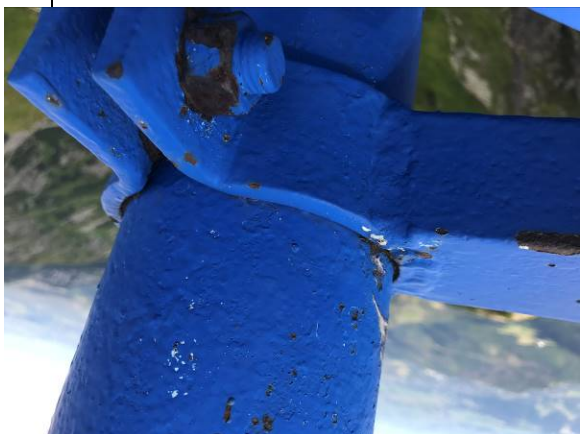
Ubytki powłok malarskich elementów stalowych masztu i ramy łukowej
