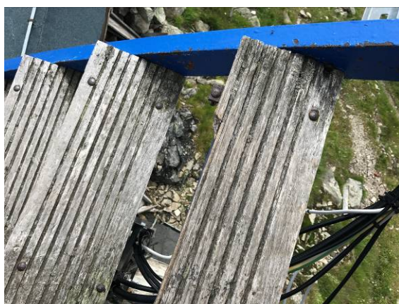
Stopnie drewniane schodów prowadzących na stropodach rotundy – brak powłok zabezpieczających drewno przed korozją biologiczną
