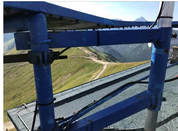
Konstrukcja wsporcza blatów do mocowania urządzeń pomiarowych
