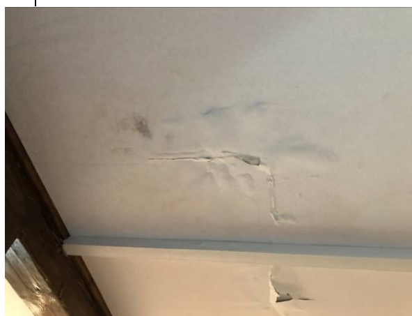
Zacieki i pęknięcia na stropie (płyty G-K) w przybudówce
