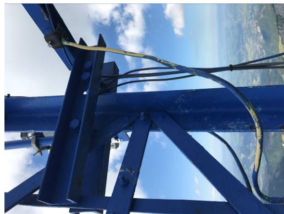
Ubytki powłok malarskich elementów stalowych masztu i ramy łukowej i ogniska korozji
