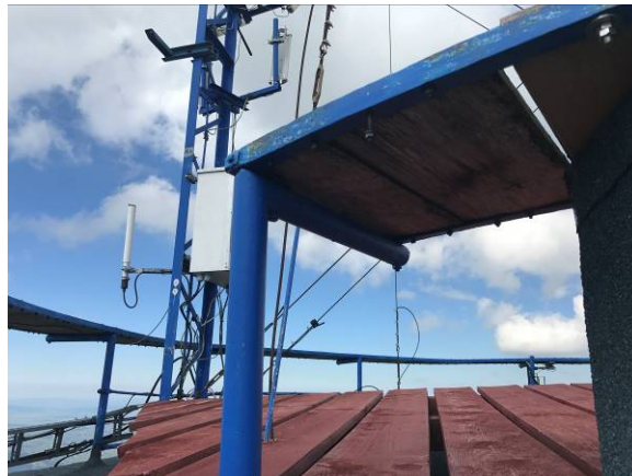
Konstrukcja wsporcza blatów do mocowania urządzeń pomiarowych
