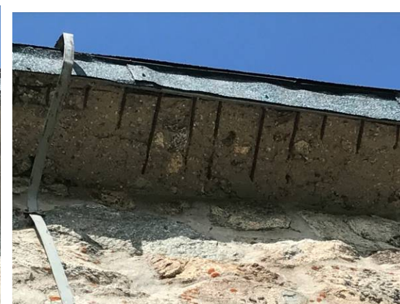
Brak otuliny zbrojenia w okapach płyty stropodachu
