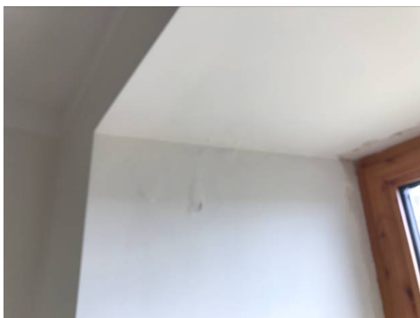
Ślady zawilgoceń na ścianach i przy oknie w pokoju | 18 | 19 | Ślady zawilgoceń na ścianach i przy oknie ' pokoju
