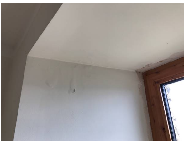
Ślady zawilgoceń na ścianach i przy oknie w pokoju | 18 | 19 | Ślady zawilgoceń na ścianach i przy oknie ' pokoju
