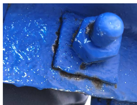
Ubytki powłok malarskich elementów stalowych masztu i ramy łukowej
