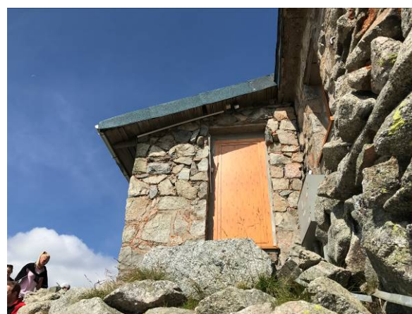
Widok elewacji i ubytki w spoinowaniu
