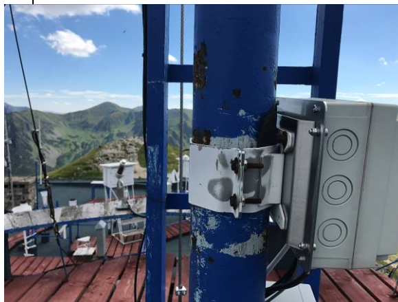
Ubytki powłok malarskich w miejscu mocowania urządzenia pomiarowego
