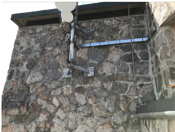
Widok elewacji i ubytki w spoinowaniu
