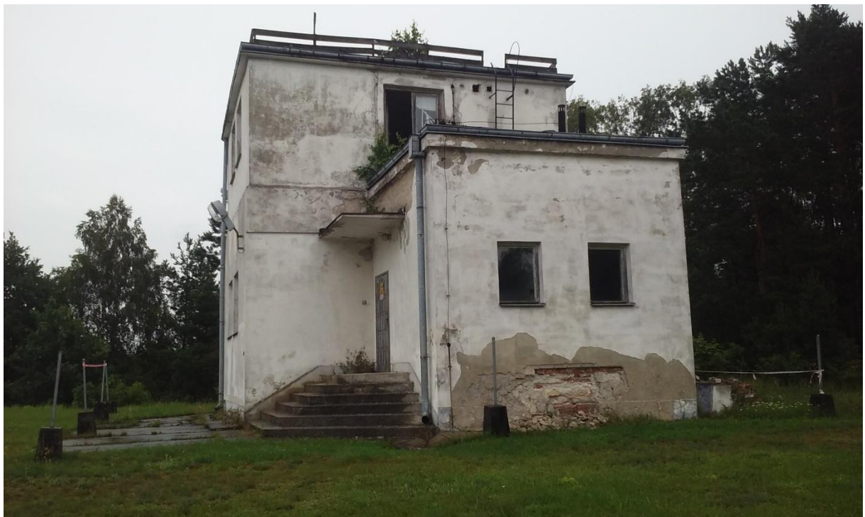
Zdjęcie nr 2. Elewacja od strony południowo - wschodniej
