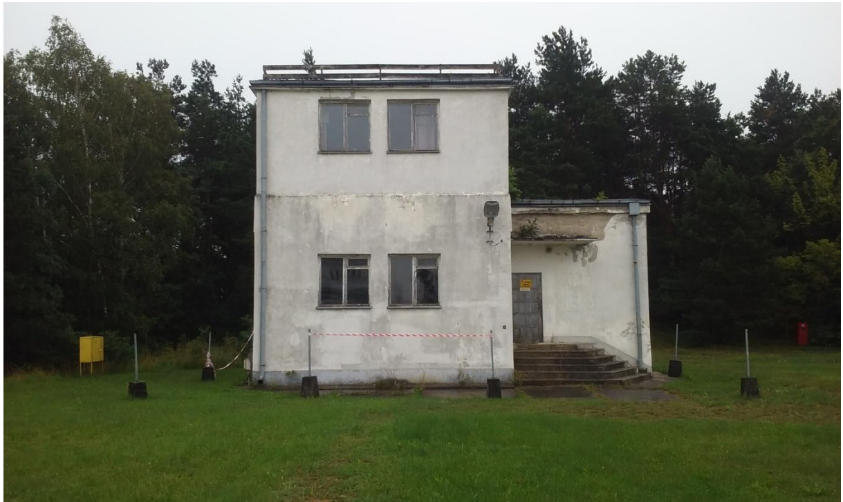
Zdjęcie nr 1. Elewacja od strony północno - wschodniej
