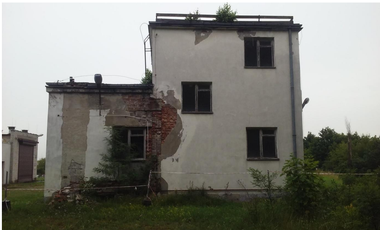
Zdjęcie nr 3. Elewacje od strony południowo - zachodniej
