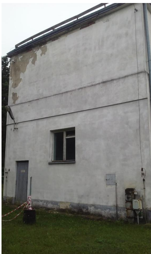
Zdjęcie nr 4. Elewacja od strony północno - zachodniej
