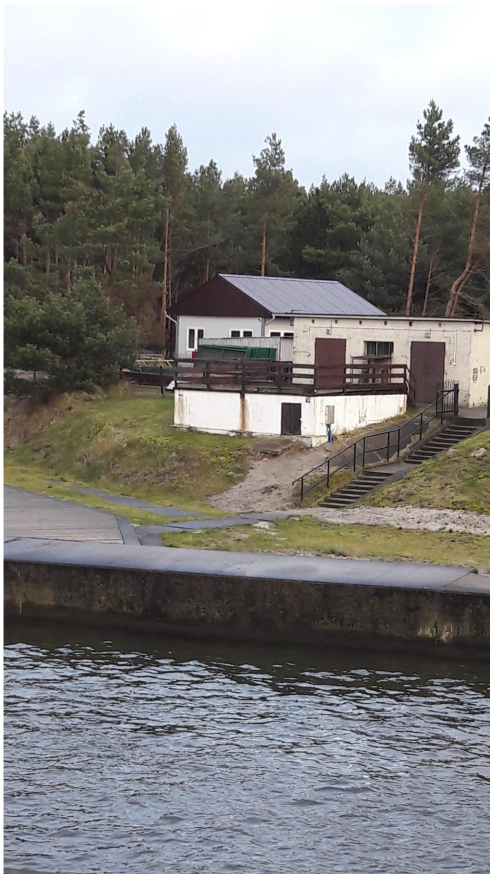
Zdj.11 Budynek stacji hydrologiczno-meteorologicznej w Dźwirzynie ( ze skośnym dachem ) od strony portu.
