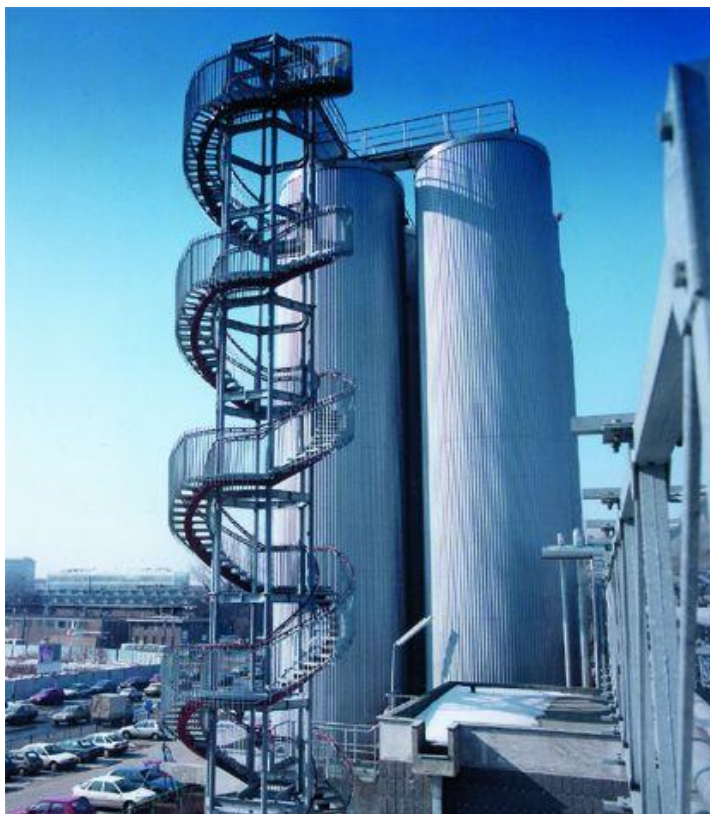
Zdj. 1 konstrukcja wieży z bocznym podparciem
