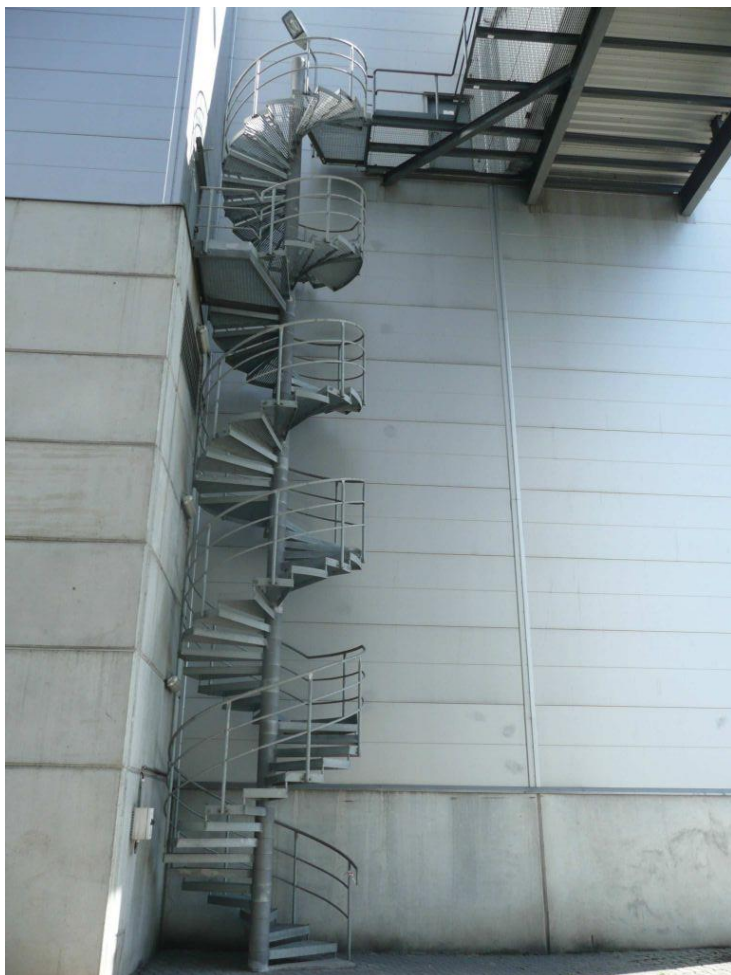
Zdj. 3 Konstrukcja wieży z bocznym podparciem prawdopodobnie z gotowych standardowych elementów cynkowanych (ważne w bezpośredniej bliskości Morza Bałtyckiego)
