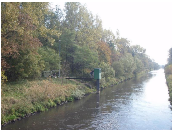
Stacja hydrologiczna rzeczna Jeleń – widok na stację w dół rzeki.
