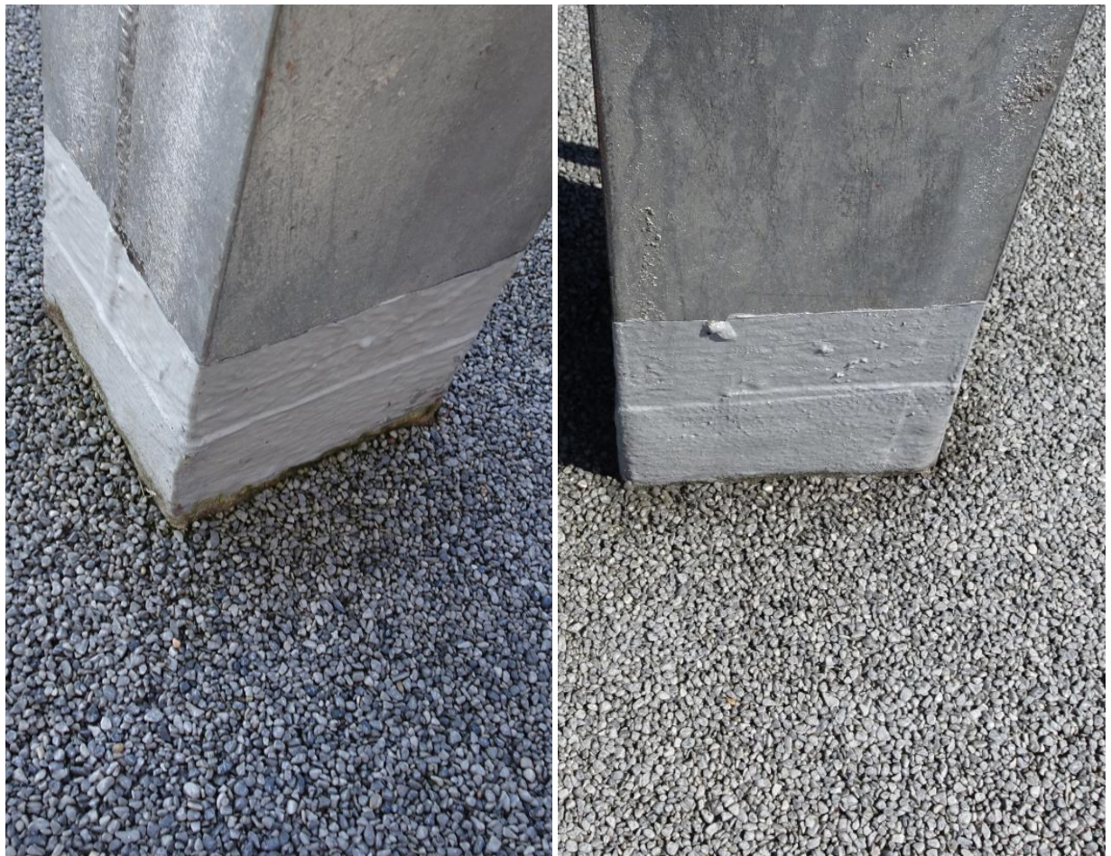
Rys. 6. Przejście słupków pomostu badawczego przez warstwy tarasu.
