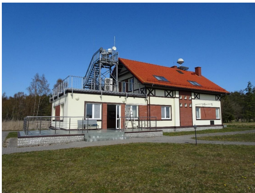
Rys. 1. Budynek stacji badawczo-meteorologicznej.
