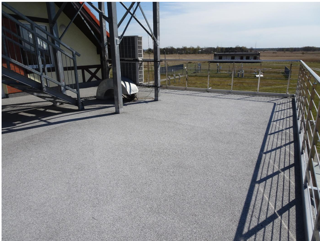
Rys. 4. Taras nad pomieszczeniem biurowym.
