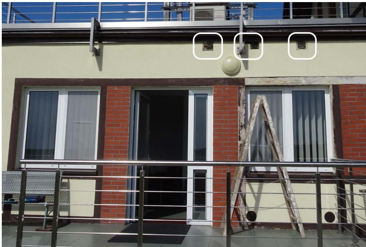
Rys. 3. Lokalizacja odkrywek na elewacji południowej.
