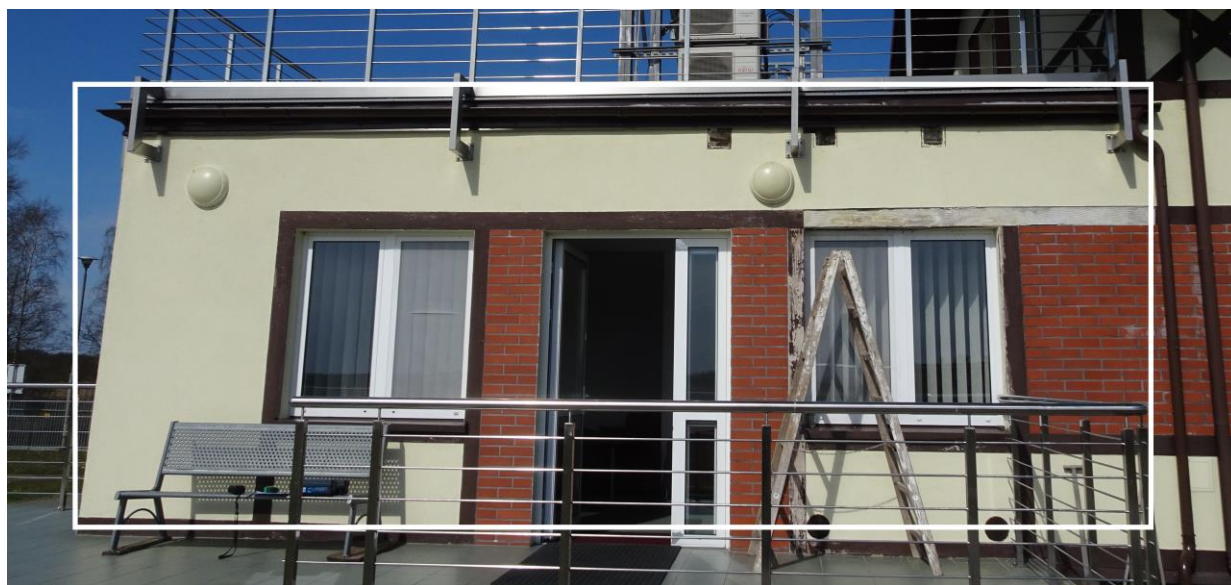
Rys. 20. Zakres prac remontowych- naprawczych, elewacja południowa.
