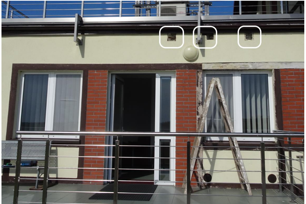
Rys. 3. Lokalizacja odkrywek na elewacji południowej.
