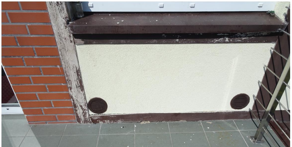
Rys. 13. Otwory wentylacyjne wykonane w celu odprowadzenia wilgoci, zgromadzonej w ścianie.
