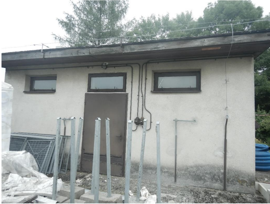
Fot. 4 Schron wodorowy przy SHM Krosno - elewacja południowa
