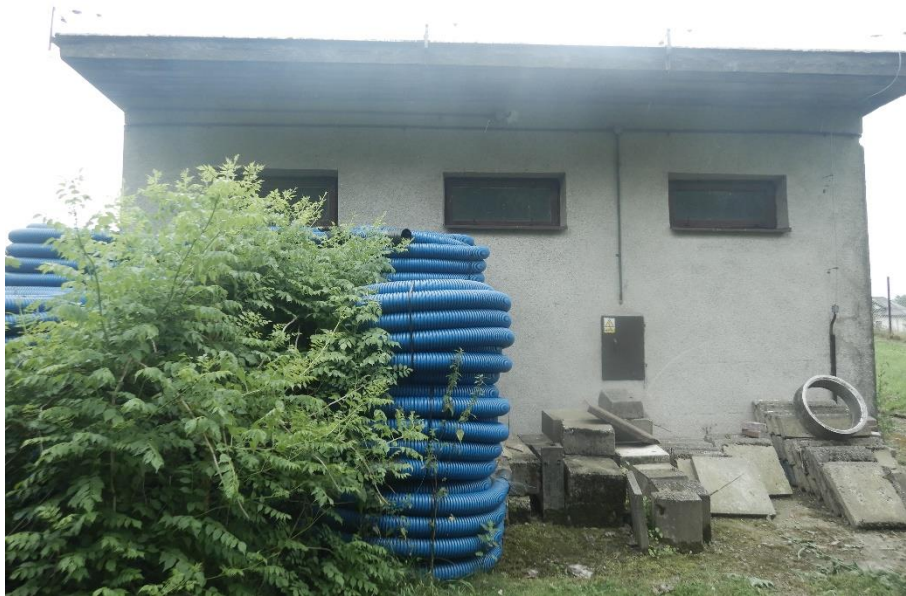
Fot. 2 Schron wodorowy przy SHM Krosno - elewacja północna
