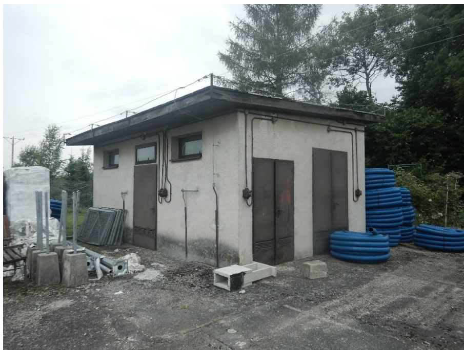
Fot.1 Schron wodorowy przy SHM Krosno - widok ogólny
