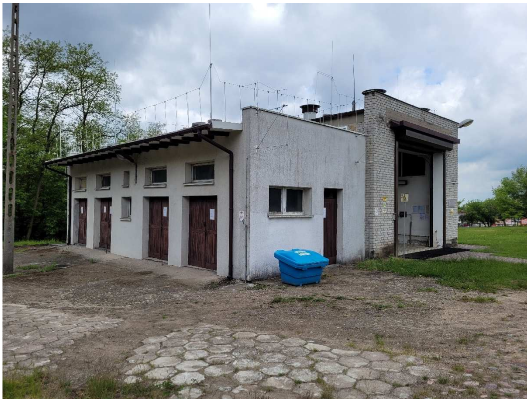
foto. nr 1 – widok ogólny na bramę balonowni oraz pom. gospodarcze
