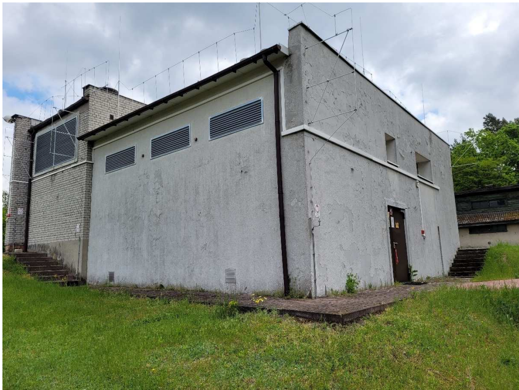
foto. nr 2 – widok ogólny na wejście do magazynu butli
