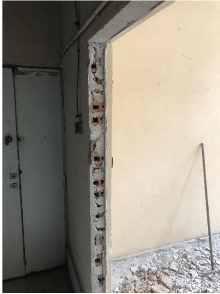
Ściana wydzielająca pomieszczenie magazynowe od pozostałych pomieszczeń objętych opracowaniem
