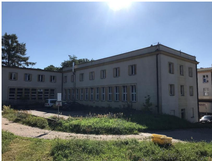
Widok od strony skarpy, część północna (parking pod planowane zaplecze budowy)
