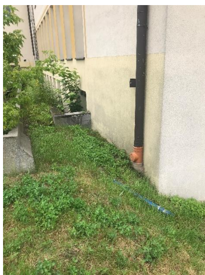
Studzienki doświetlające od strony północnej
