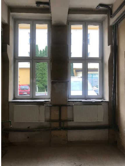
Warsztat – pomieszczenie nr 019
