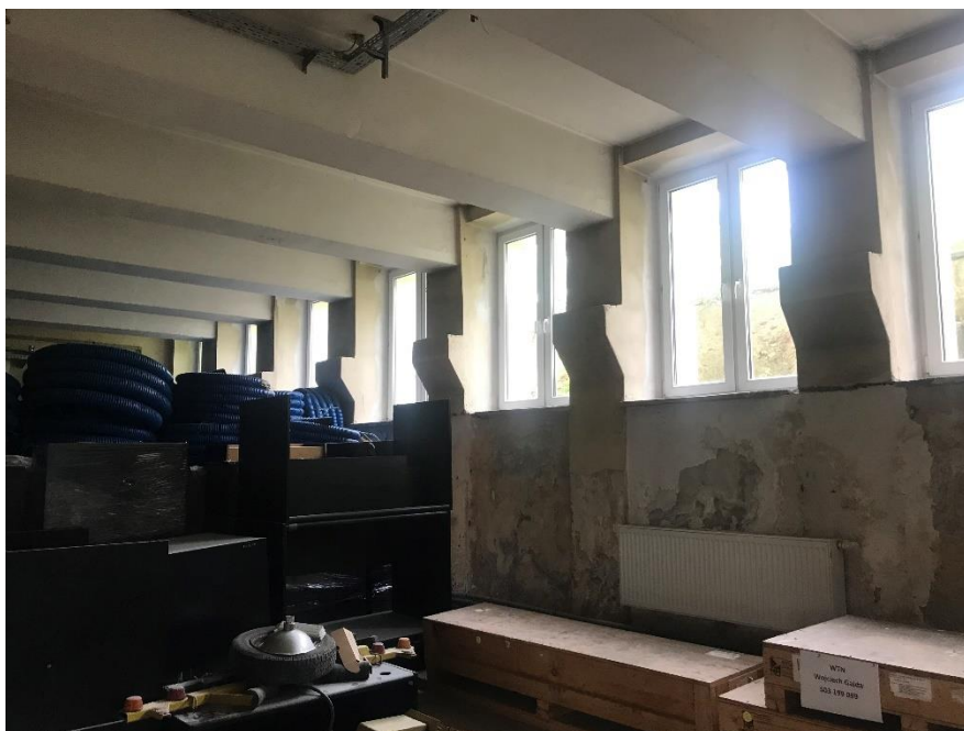
Wnętrze magazynu – pomieszczenie nr 018 (widok na okna od strony północnej)
