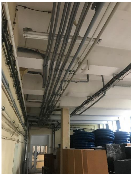
Wnętrze magazynu – pomieszczenie nr 018 (widok na wejście od strony klatki schodowej)
