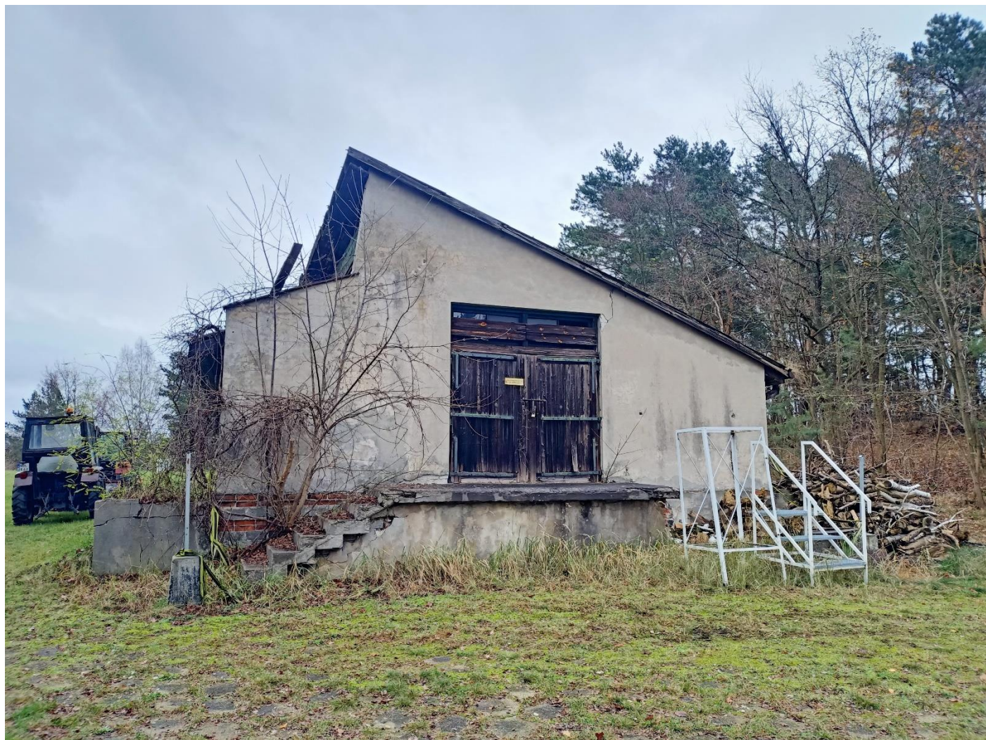
Zdjęcie 5 Elewacja południowa
