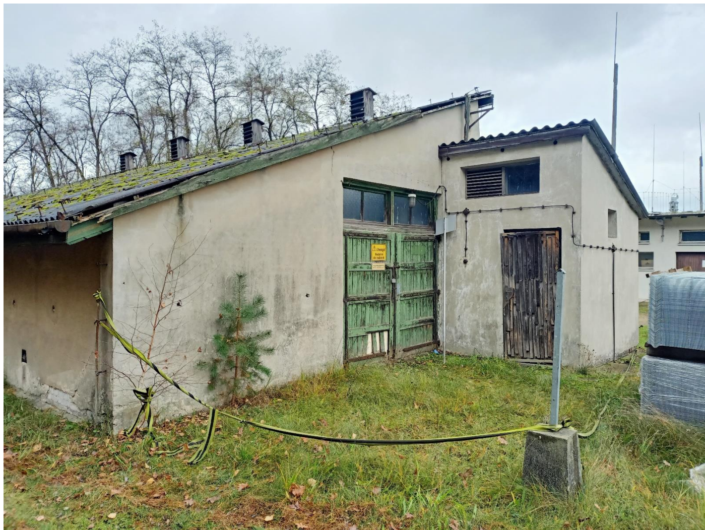
Zdjęcie 3 Elewacja północna
