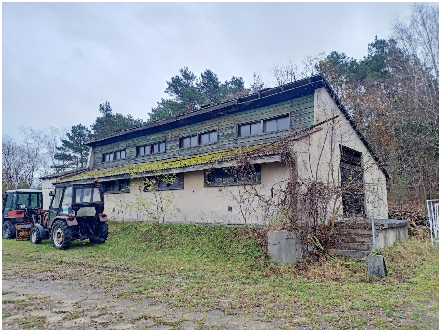
Zdjęcie 6 Elewacja południowa i zachodnia
