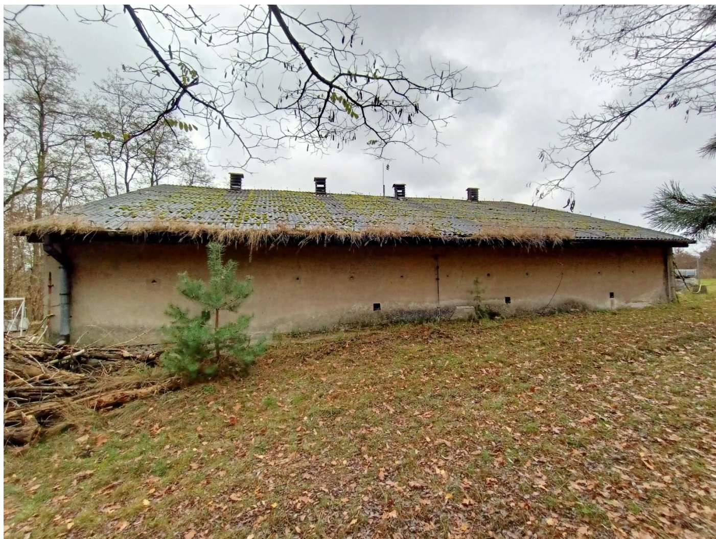
Zdjęcie 4 Elewacja wschodnia
