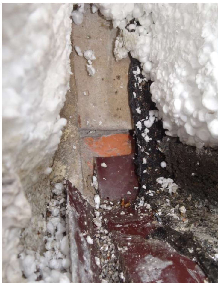
Rys. 12. Widok na ścianę po wykonaniu odkrywki.
