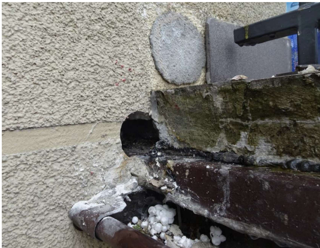
Rys. 11. Lokalizacja odkrywki punktowej przyłączeniu krawędzi balkonu z elewacją.
