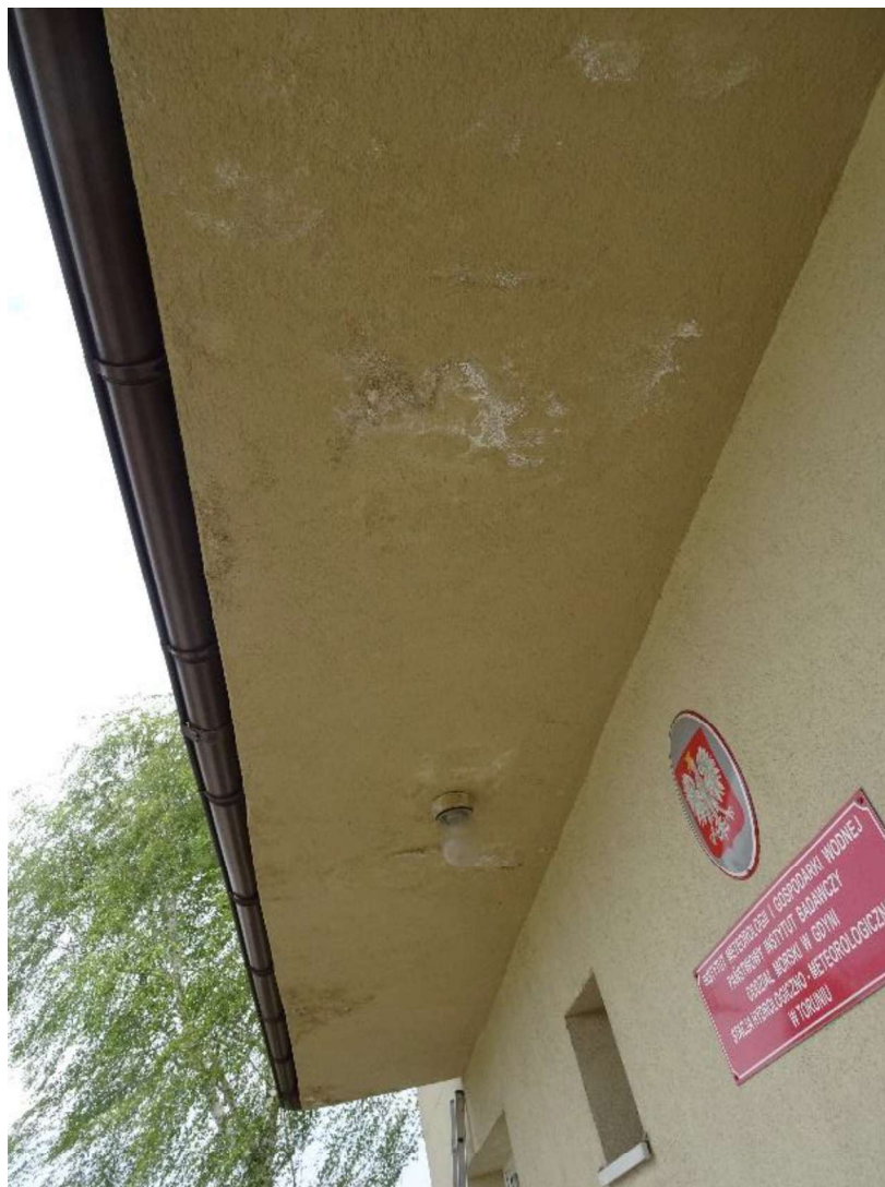
Rys. 5. Odspojenia farby i wykwyty soli wapiennych na spodzie balkonu.
