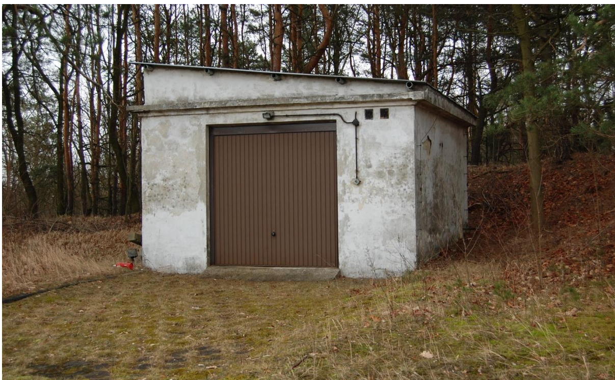
Magazyn (schron wodorowy) – budynek wyłączony z użytkowania – przeznaczony do rozbiórki
