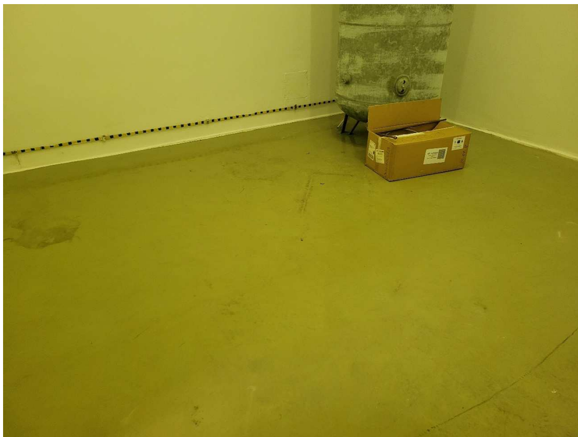
foto. nr 7 – widok na podłogę magazynu wodoru (pom. nr 8) wykończenie z żywicy
