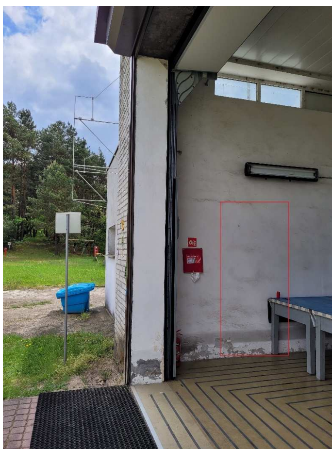
foto. nr 9 – widok na ścianę pom. balonowni (kolorem czerwonym oznaczono projektowany otwór drzwiowy)
