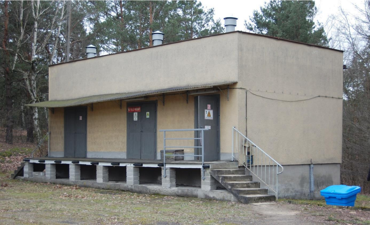
Magazyn butli wodorowych
