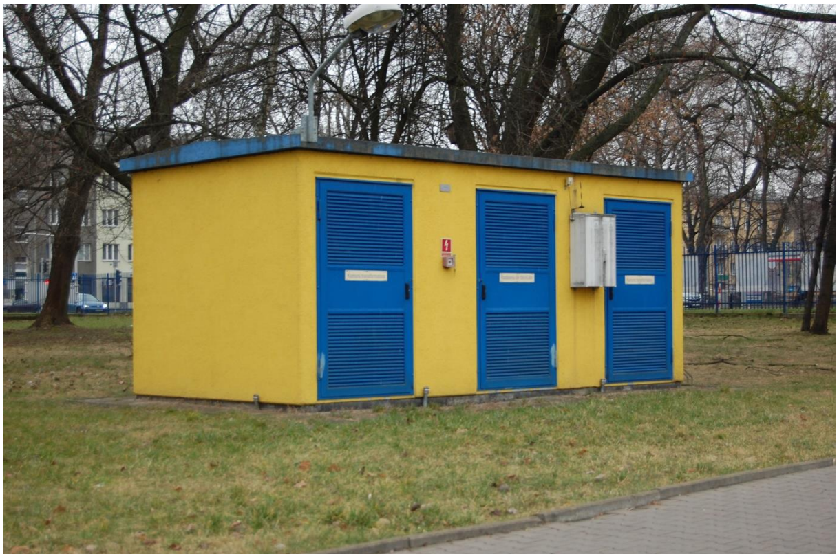
Kontenerowa stacja trafo
