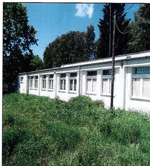
6. Tył budynku, elewacja wschodnia
